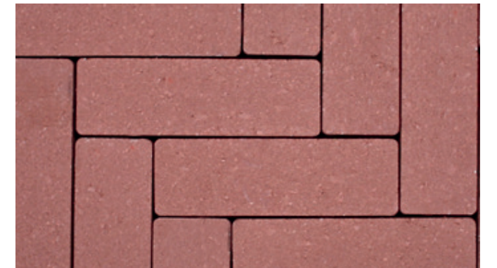
Parkeerstrook, betonstraatsteen rood - bruin. uitgevoerd in ellenboogverband
